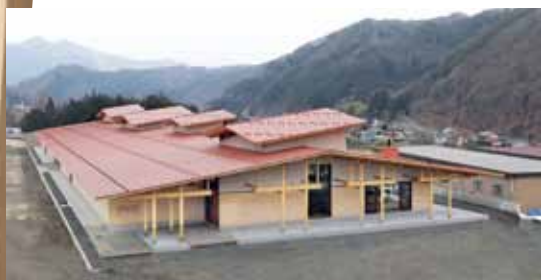
写真1 木曽町役場本庁舎・防災センターの新庁舎
