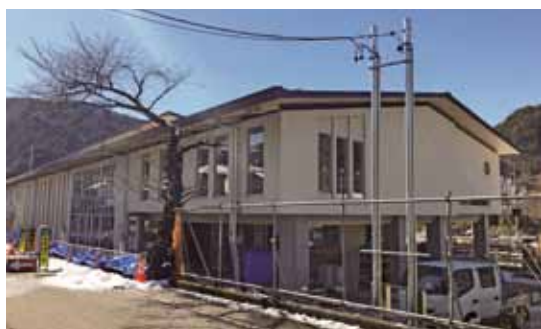
写真3 建設中の上松町新庁舎
