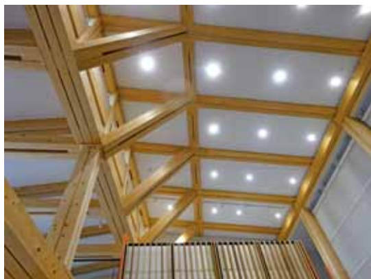
写真4 「合わせ柱」等が見える上部架構
