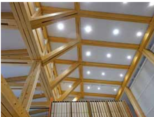
写真4 「合わせ柱」等が見える上部架構
