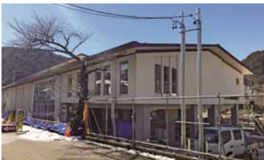
写真3 建設中の上松町新庁舎
