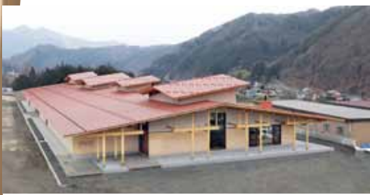
写真1 木曾町役場本庁舎・防災センターの新庁舎
