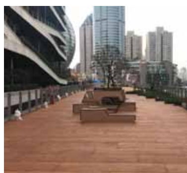
高耐久木材を使用したデッキ
