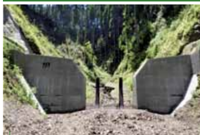
流木捕捉式治山ダム(福岡県朝倉市)
