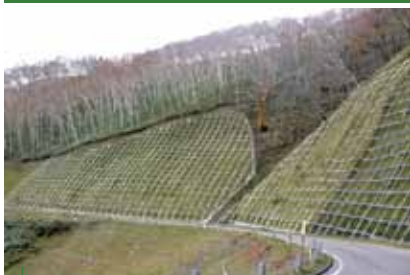
崩壊防止のための法枠工
