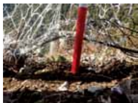
写真1 防護柵と地面との隙間
