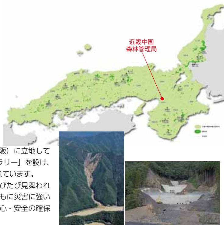
災害復旧事業(奈良県十津川村)
