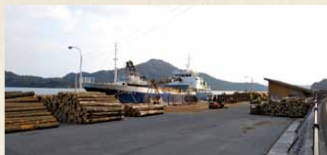
島外出荷のための港土場
