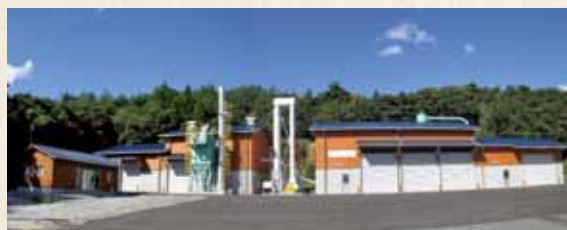
隠岐の島町木質バイオマス利用推進センター (ペレット製造工場)
