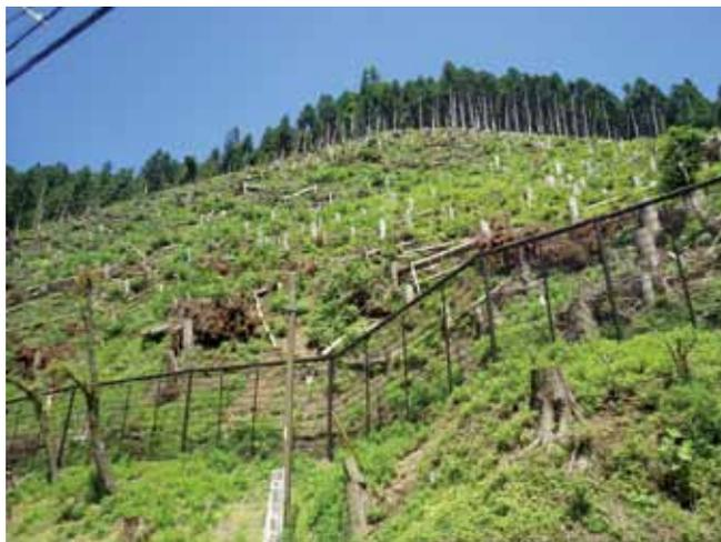
写真4 落石防護柵設置、風倒木処理後
