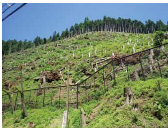
写真4 落石防護柵設置、風倒木処理後
