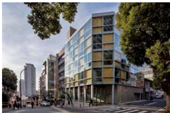
CLTの木質感を表出させた外観
