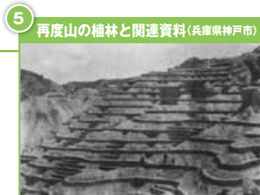
明治36年(1903年)時点の積苗工の施工状況
