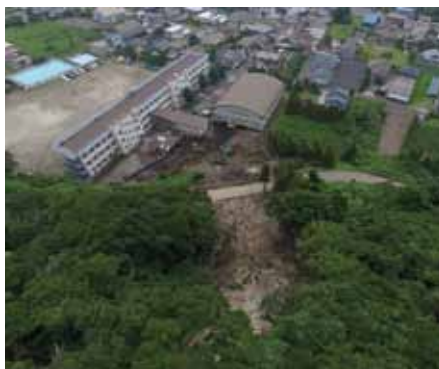
令和元年7月梅雨前線豪雨災害（山腹崩壊）により施設に被害（鹿児島県垂水市）
