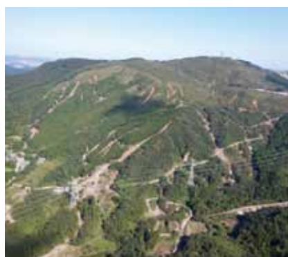
令和元年東日本台風（台風第19号）により山腹崩壊が発生（宮城県丸森町）
