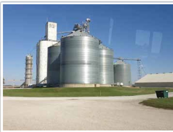
6 米国アイオワ州(デモイン)におけるバイオエタノール精製プラント
