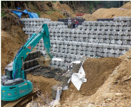
治山施設の整備
