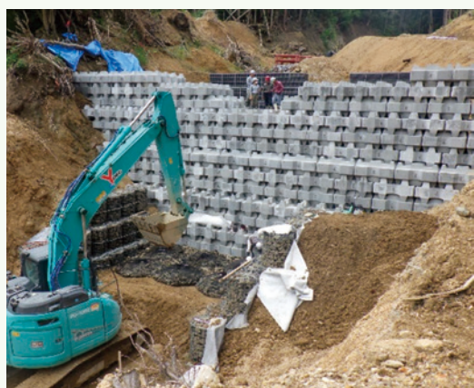
治山施設の整備
