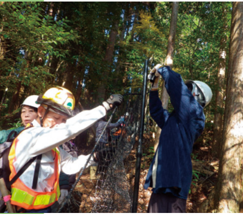
シカ防護柵の設置作業
