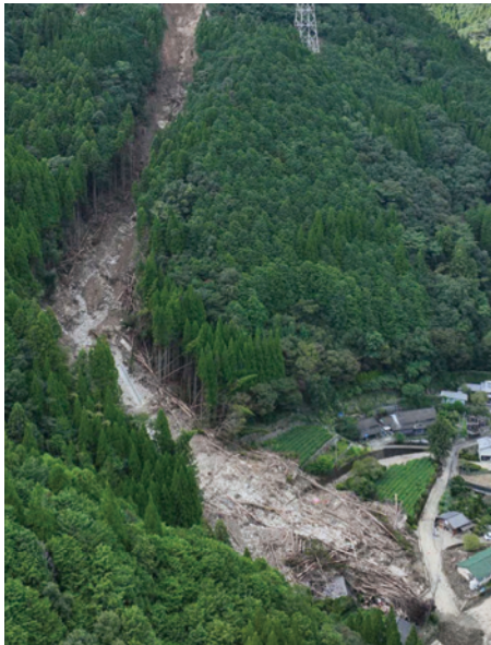
令和7年8月の大雨による土砂流出被害（熊本県八代市）
