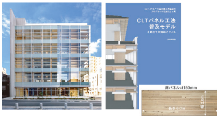
写真(左)：CLTを活用した建物 鍵利CLT BLDG. (埼玉県さいたま市) 写真(右)：CLTパネル工法普及モデルと標準寸法のCLTパネル
