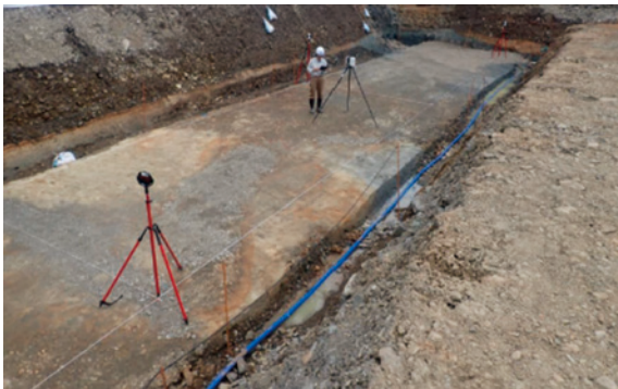
地上レーザースキャナーを用いた3次元出来形管理
