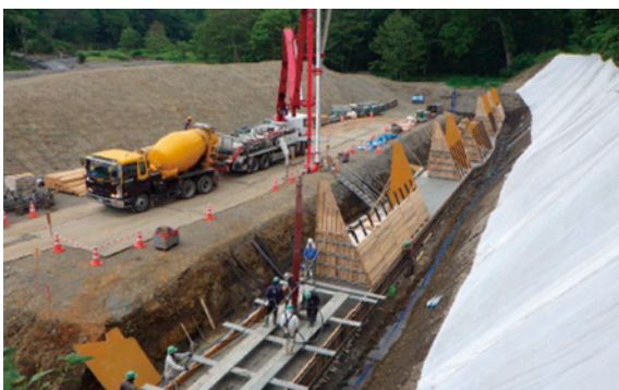
大型のコンクリート圧送車を使用した打設
