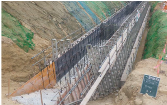
レールに沿って型枠や足場を上昇させることができるスライド型枠を採用
