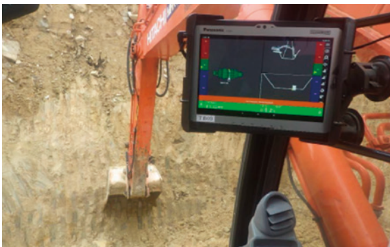
自動追尾式トータルステーションを活用したICT建設機械の活用
