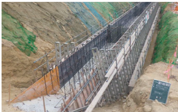
レールに沿って型枠や足場を上昇させることができるスライド型枠を採用
