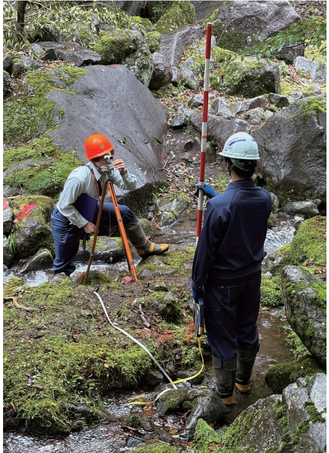
溪間工の設計のための現地測量
