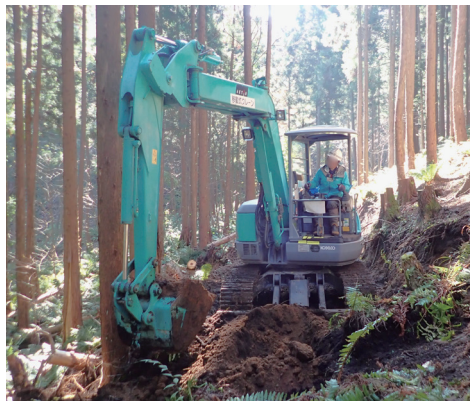
研修生による森林作業道の作設
