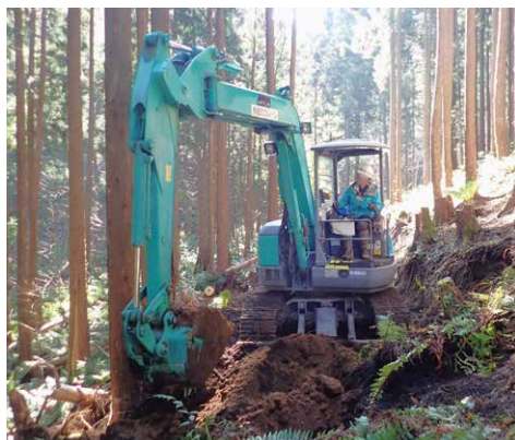
研修生による森林作業道の作設
