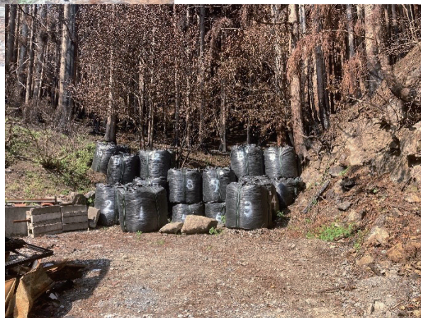
応急対策実施後
