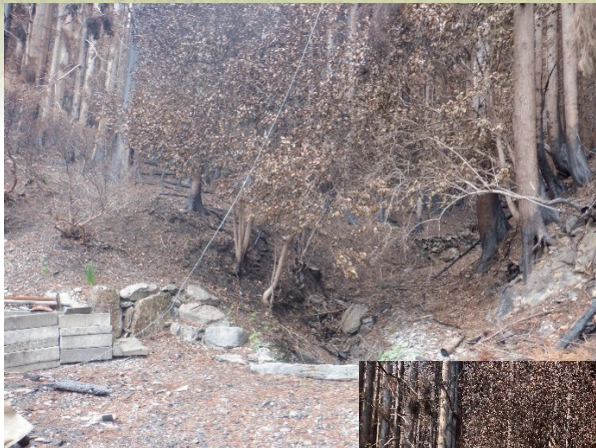
応急対策対策前
