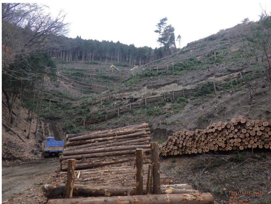
11月から開始された被災木の伐採
