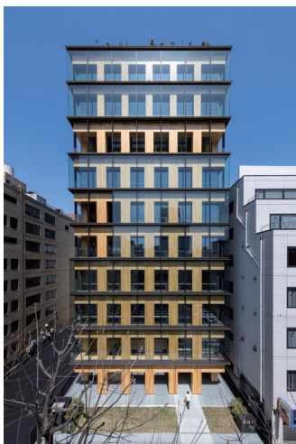
(株)大林組「Port Plus®」 写真：(株)エスエス 走出 直道
