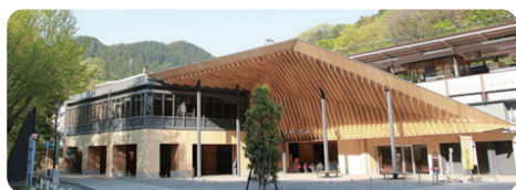
内外装に多摩産材を活用した高尾山口駅の駅舎
