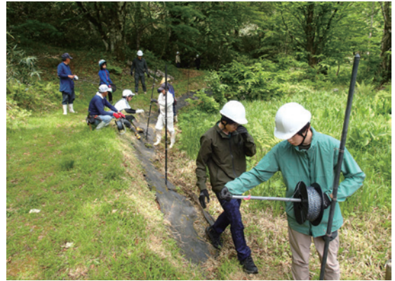
山中峠の湿原での電気柵設置作業
