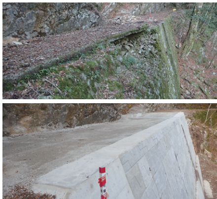
林道の改良工事(上:実施前 下:実施後)
