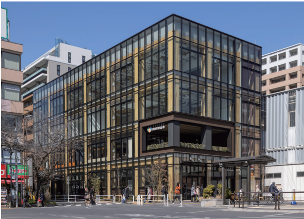
(写真1)上：耐火集成材によるトラス架構を用いた4階建て公共施設 下：木質耐火柱と、集成材により耐火被覆した鉄骨梁によるハイブリッド木造技術を採用した4階建て商業ビル
