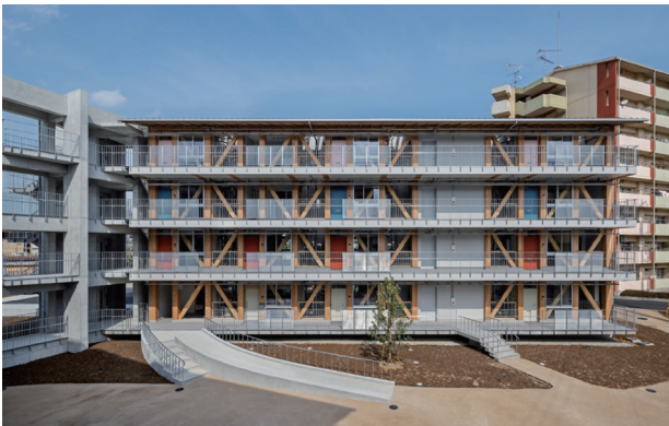
(写真2) 平成30年の建築基準法改正により可能となった長時間耐火構造による燃えしる設計を用いた全国初の木造4階建て集合住宅(徳島県新浜町団地県営住宅2号棟) 出典: ウッドデザイン賞受賞作品データベース ( https://www.wooddesign.jp/db/production/1887/ )
