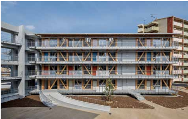
(写真2) 平成30年の建築基準法改正により可能となった長時間耐火構造による燃えしる設計を用いた全国初の木造4階建て集合住宅(徳島県新浜町団地県営住宅2号棟) 出典: ウッドデザイン賞受賞作品データベース ( https://www.wooddesign.jp/db/production/1887/ )
