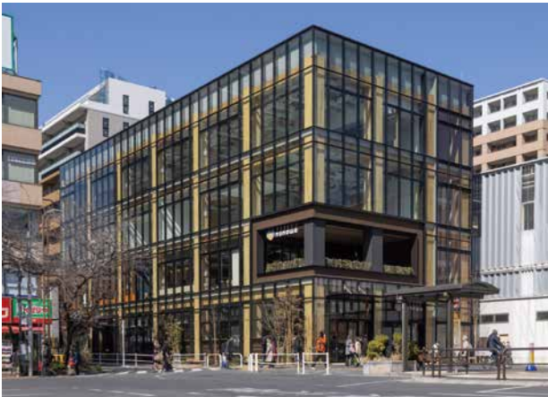
(写真1)上：耐火集成材によるトラス架構を用いた4階建て公共施設 下：木質耐火柱と集成材により耐火被覆した鉄骨梁によるハイブリッド木造技術を採用した4階建て商業ビル
