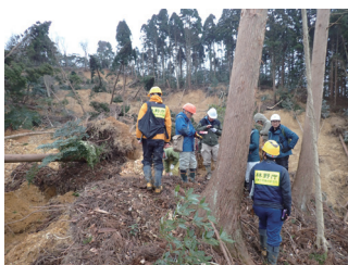
職員派遣による災害箇所調査
