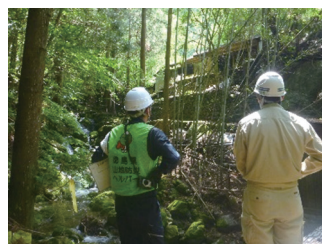
治山施設の点検
