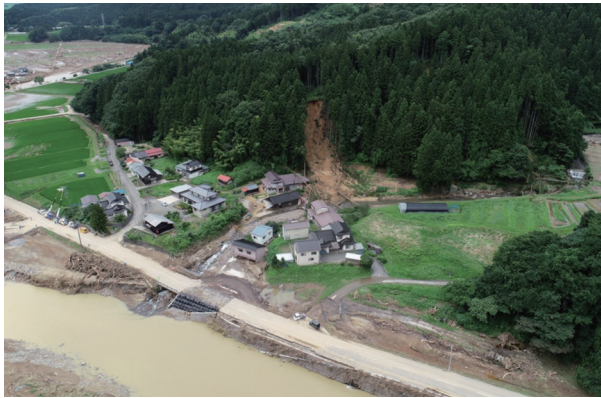
令和6年7月の大雨災害による被害(山形県酒田市)
