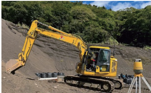
自動追尾式トータルステーションを活用したICT建設機械による施工
