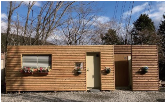
現場事務所に丸太を使用
