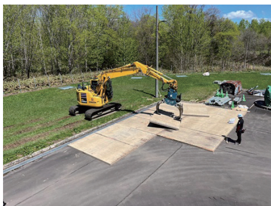
敷板としての活用 写真提供: 株式会社CLTmat
