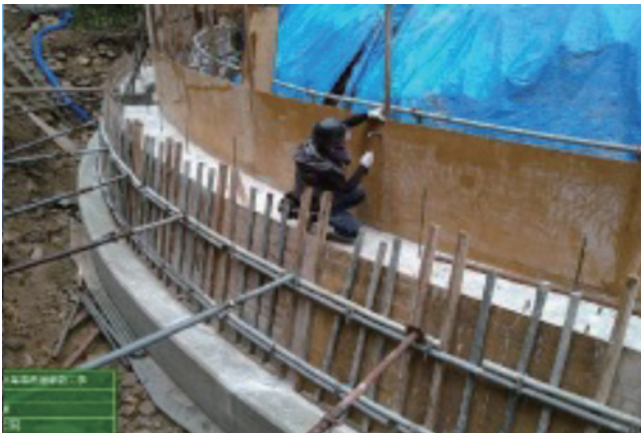
型枠や支保工を増やし、滑らかな曲線の型枠を設置
