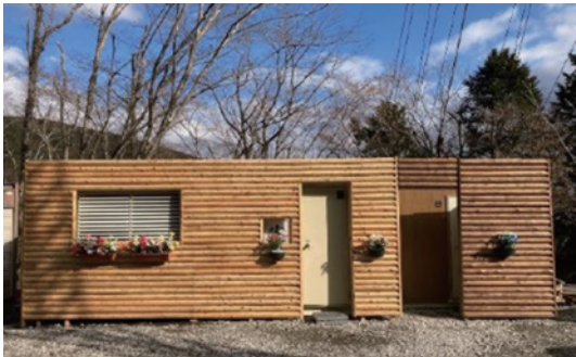
現場事務所に丸太を使用
