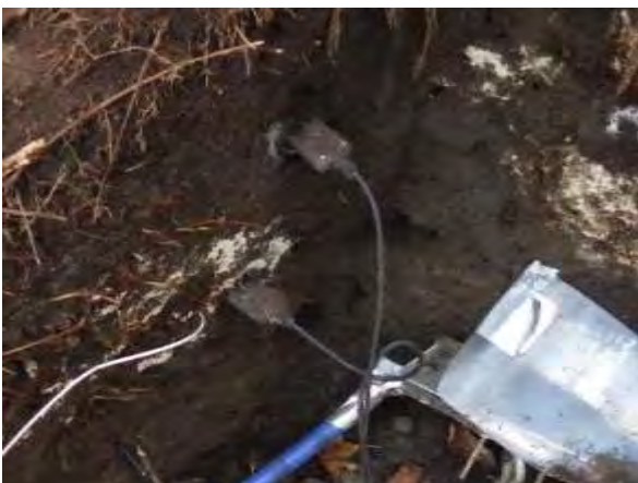
土壌水分計設置状況
