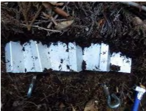
メッキ鋼板打ち込み状況
