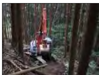
森林作業道作設
