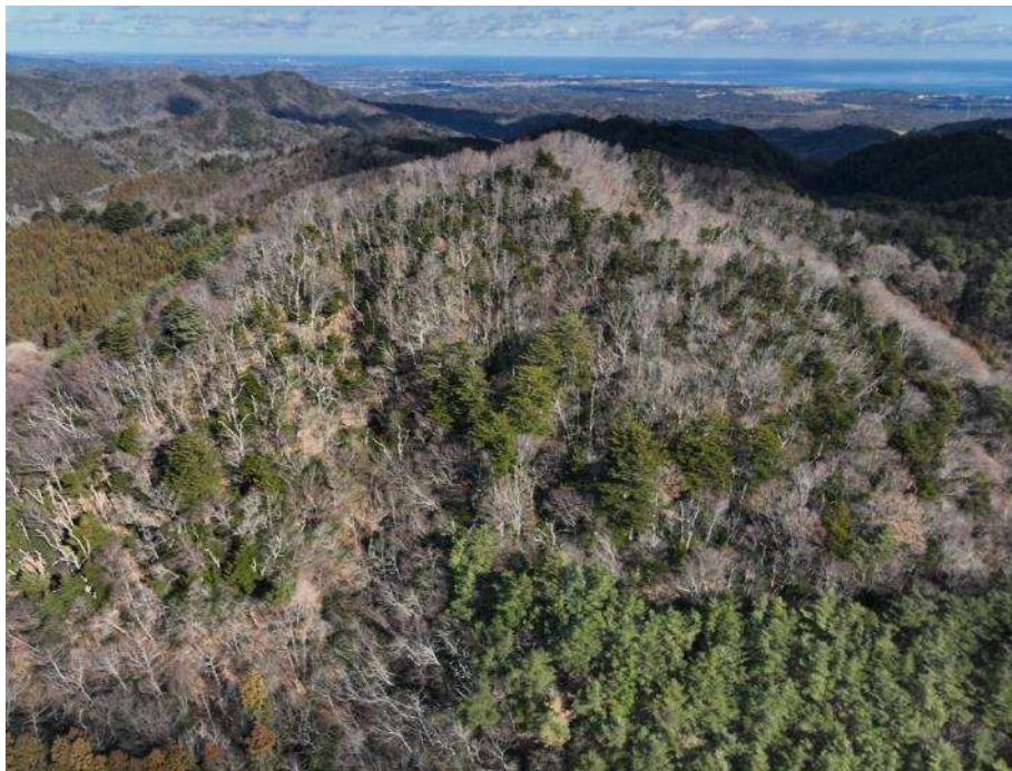
写真 6.24 日隠山（全域）整備前後
