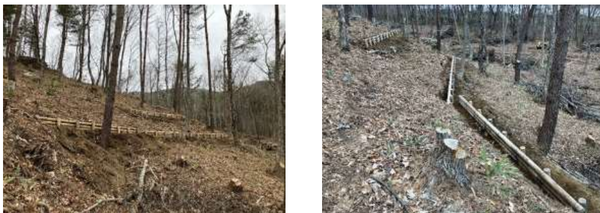
写真 3.15 丸太筋工の設置状況
