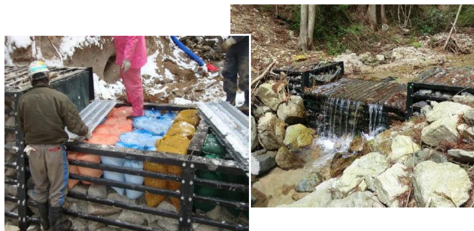
吸着材を使用した濁水防止工
