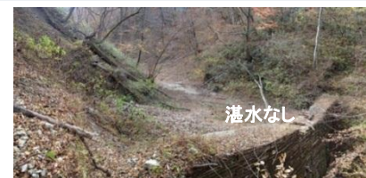
溪間工2（檜葉町）
