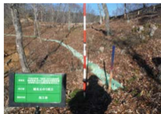
植生土のう筋工
