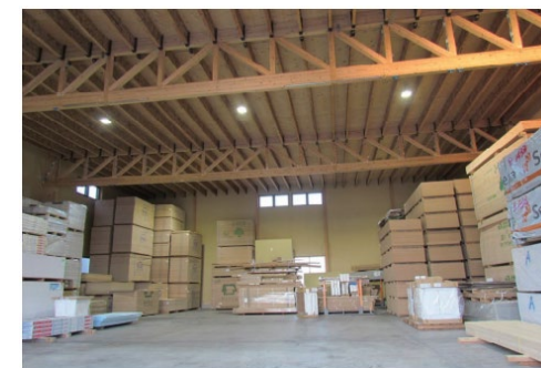
平行弦トラスによる 木造倉庫 (360㎡) (千葉県市原市)
