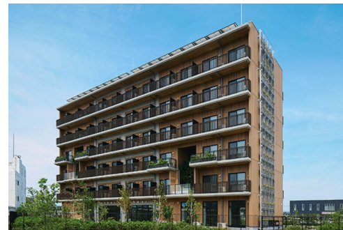
6階建て共同住宅 木造・RC造の平面混構造 (2025:茨城県つくば市)
