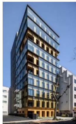
日本初の高層純木造耐火構造 (11階建て) (2022:神奈川県横浜市)
