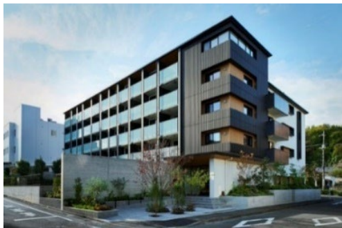
中層木造マンションの先駆的事例 1階がRC、2～5階が木造 (2021:東京都稲城市)
