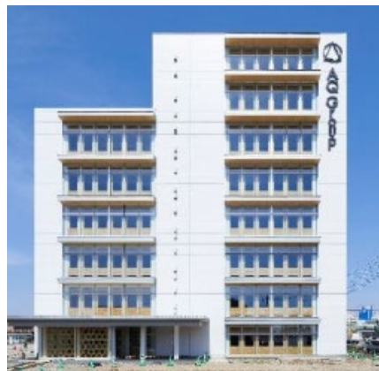
一般流通材を活用した軸組工法による 普及型耐火純木造ビル(8階建て) (2024:埼玉県大宮市)
