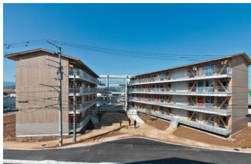
4階建て共同住宅 準耐火構造のあらわし木造4階建て (2023:徳島県新浜町)
