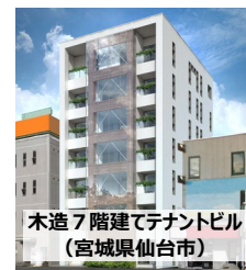
2時間耐火部材を活用した建築物 (2021年)
