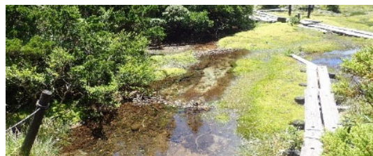
花之江河の保全対策(堰の設置)
