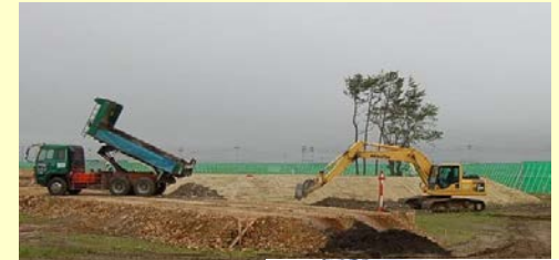
生育基盤の整備のための盛土工事
