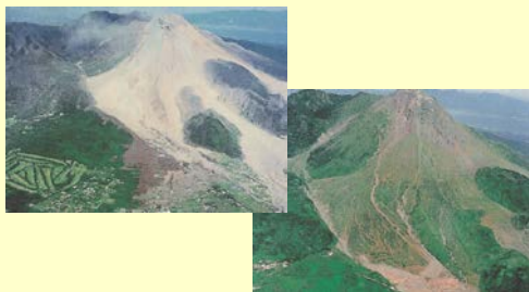
[ 土石流発生箇所における治山事業の実施 ]
