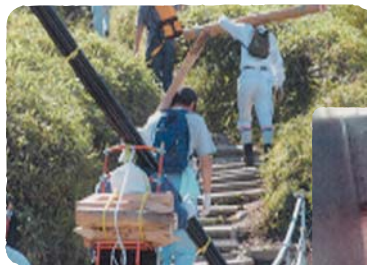
ボランティアによる トイレ修繕材料の運搬
