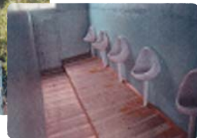
完成した剣山公衆トイレ
