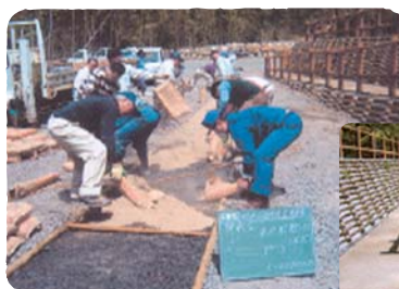
ボランティアによる 舗装資材の敷設状況
