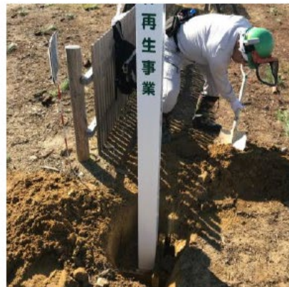
標柱設置の様子
