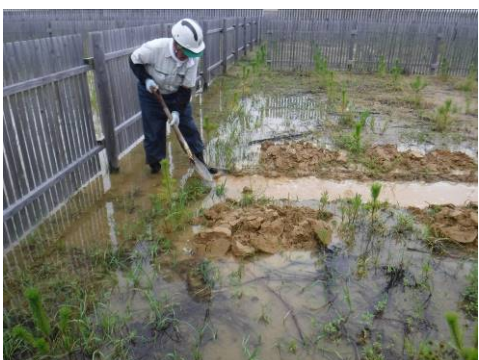
排水作業（作業中）
