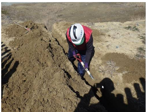
雨水処理作業（床掘り）
