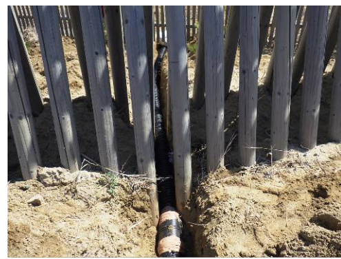
雨水処理作業（排水管理設）
