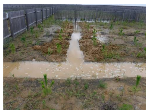
排水作業（完了）
