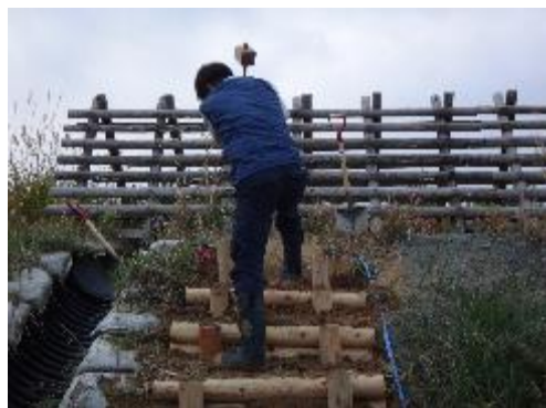
階段補修(平成30年11月)
