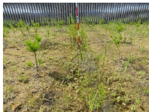
排水溝内の水(令和元年 9 月) 植栽地に施工した排水溝にたまった水
