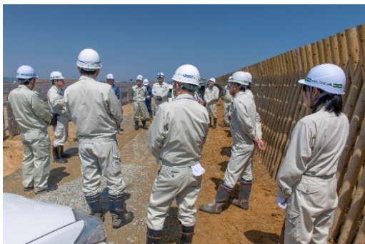
ミーティング風景(平成 30 年 4 月) 植栽作業を前にして作業手順についてのミーティング
