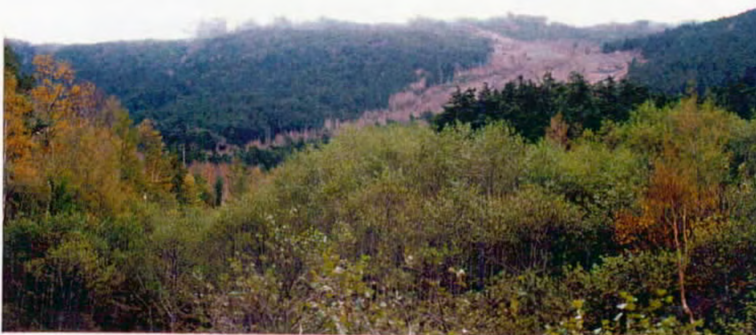
アイオン沢は 1948 年 (昭和 23 年) のアイオン台風により発生した大崩壊地、山体上部の表層に大量にあった岩塊の移動が災害の引き金になったと考えられており、上部には同様岩塊が未だ残存している。
