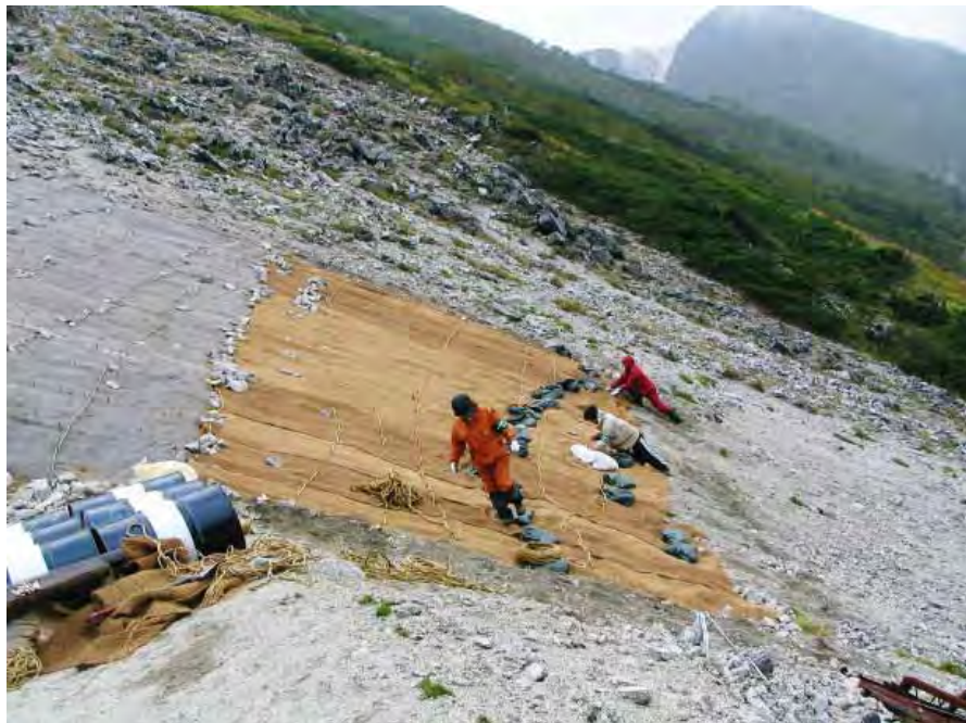
写真3 - 2 作業状況（麻むしろの固定）
