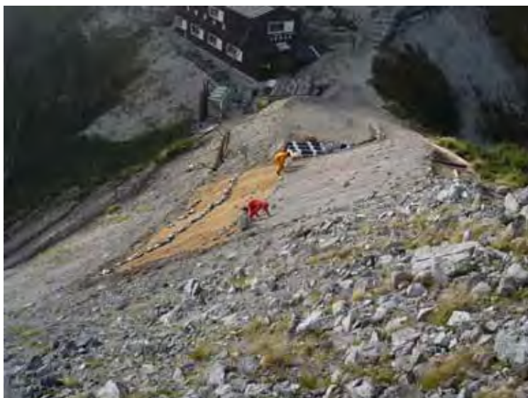
施工全景(空木岳方向から)
