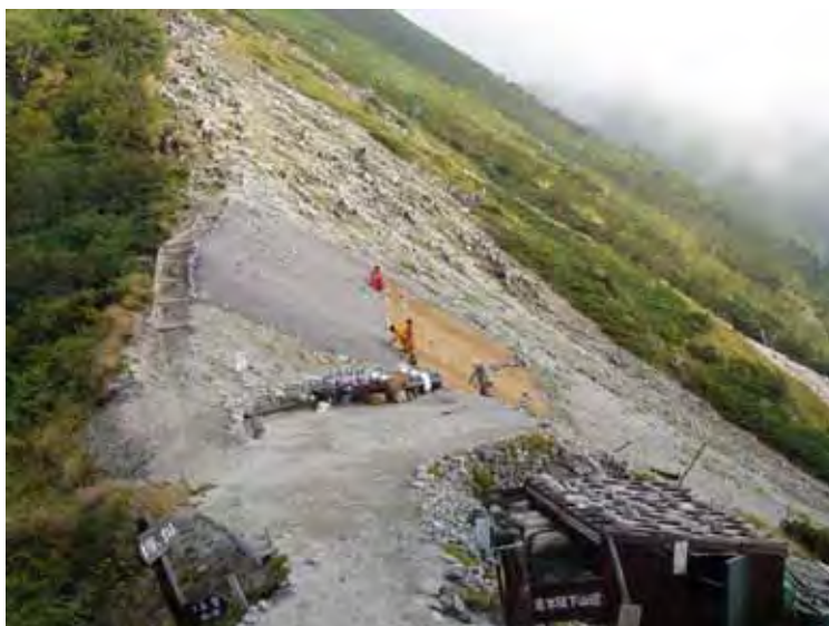
施工全景(東川岳方向から)
