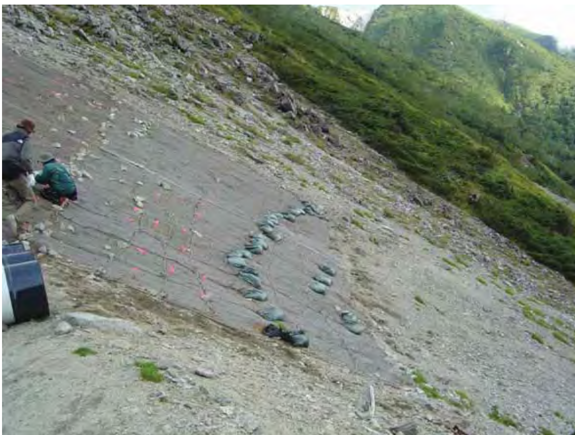
写真-5 平成 16 年度植生復元施工地
