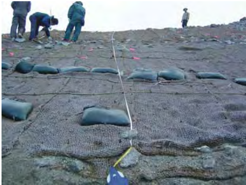
写真-3 復元施工地のセンターライン(巻尺の左右 1m が無播種区間)
