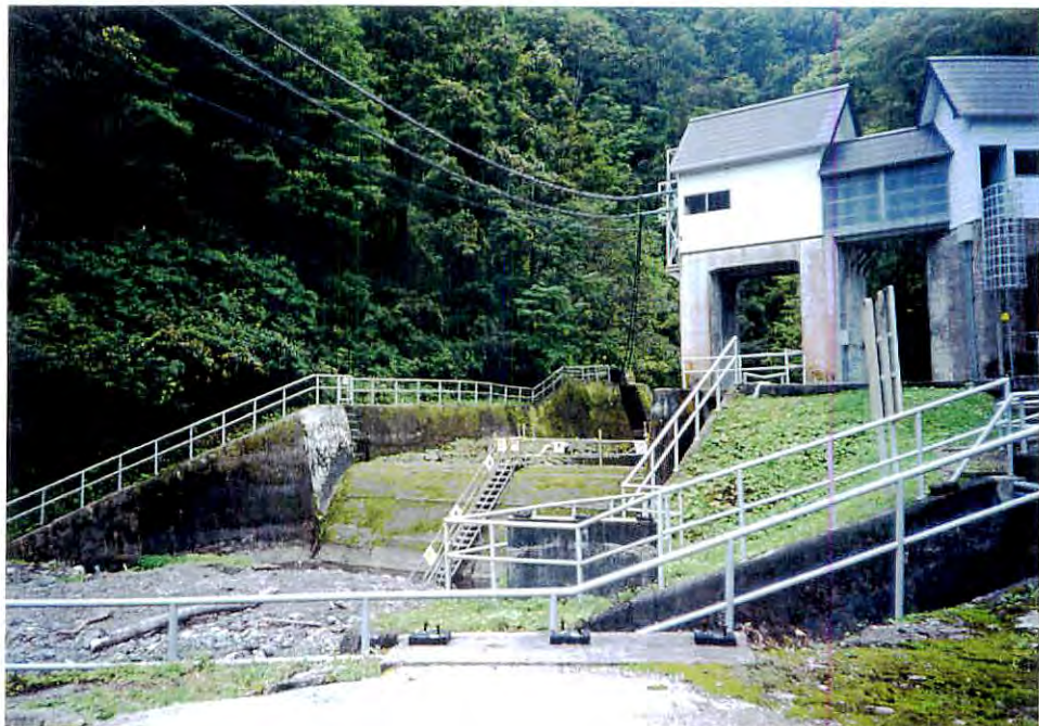
写真-29 笹内川ダム（関連ルートの起点）
