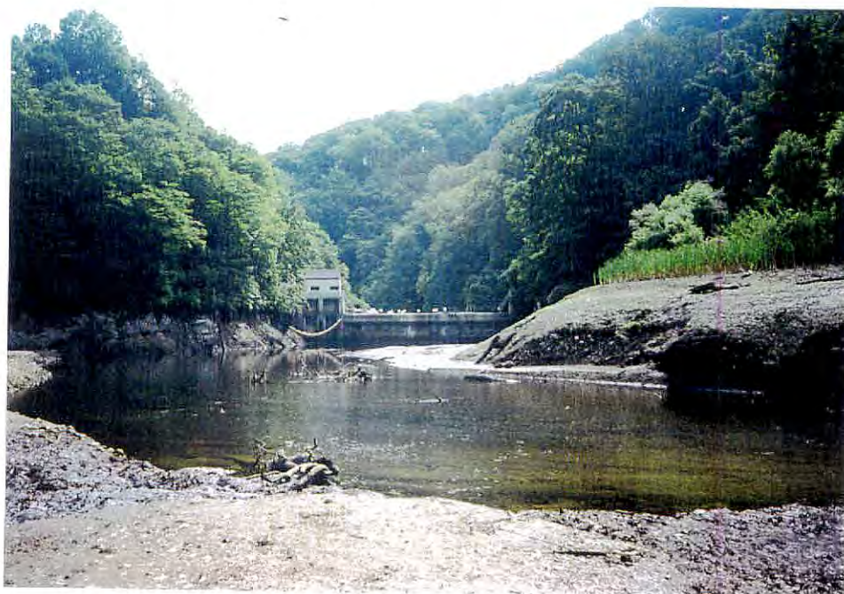
写真-60 赤石堰堤を望む
