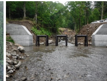
流木捕捉式治山ダム工
