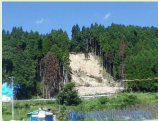
山腹崩壊の様子
