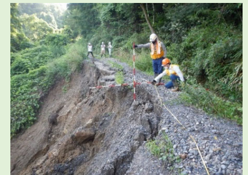
現地調査の様子
