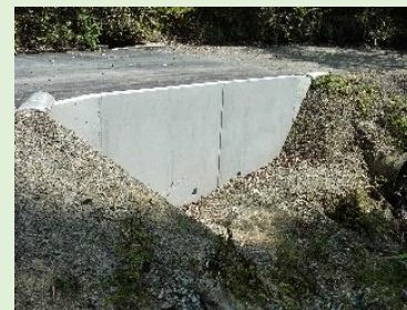
完成後の擁壁工
