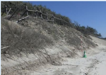
侵食された海岸防災林の様子
