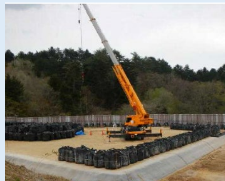
仮置き場における汚染土壌等の集積作業
