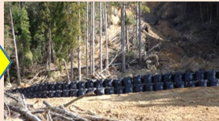
応急対策完成の様子
