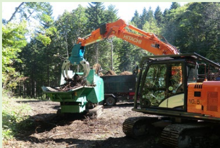
販売された未利用材のチップ化と搬出の様子
