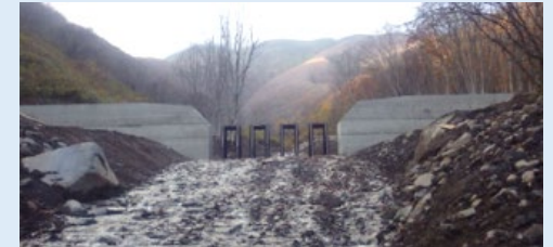
流木捕捉式治山ダムの施工完了後の様子 (青森県弘前市)
