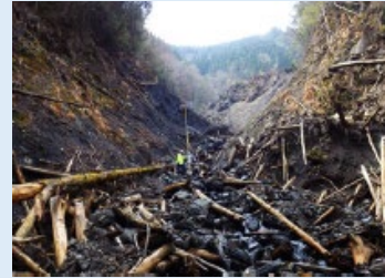
緊急的に流木対策が必要な溪流の様子 (高知県安芸郡馬路村)
