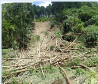
山腹崩壊の様子
