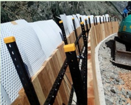
施工中の様子
