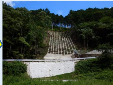
山腹工施工完了後の様子 (広島県神石高原郡神石高原町)
