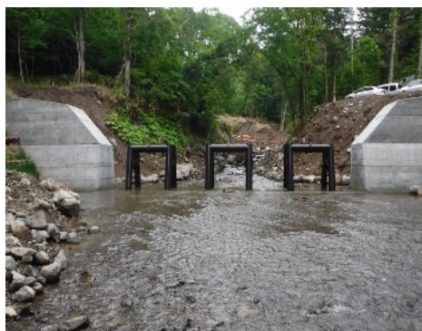
流木捕捉式治山ダム工
